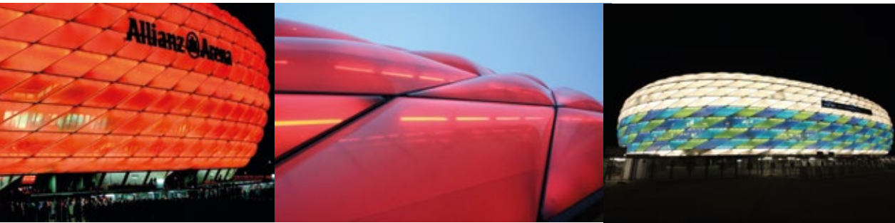
Альянц-Арена / Мюнхен. 2005. Проект – Herzog & de Meuron Architekten Фасад состоит из 2 760 ячеек, затянутых пленкой ETFE толщиной 0,2 мм. Каждый сегмент подсвечивается отдельно, что оставляет пространство для самых разнообразных вариаций. Обеспечивают такую цветовую игру флуоресцентные лампы, прикрепленные к основной несущей конструкции. На каждом кронштейне находятся две группы (обоймы) – по три лампы с параболическими отражателями. Одна группа подсвечивает низ подушки, а вторая – верх, обеспечивая равномерность свечения.
