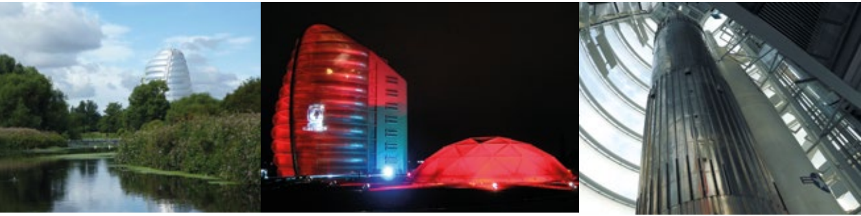
Национальный космический центр / Великобритания. 2001. Проект Николаас Гримшоу В башне, где установлены две ракеты, в дальнейшем могут быть размещены новые, еще большие по объему экспонаты. Поэтому северный фасад сконструирован так, чтобы мембраны (ETFE) можно было бы демонтировать на определенной высоте.
