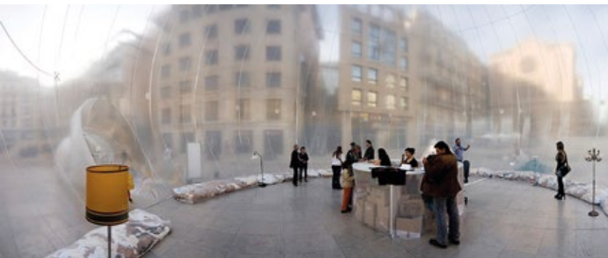
Animac Bubble в Лериде / Испания. 2006-2007 Проект – Vora Arquitectura Временный надувной павильон из ETFE-мембраны в течение двух лет служил в качестве одной их площадок Международного фестиваля анимационных фильмов ANIMAC.
