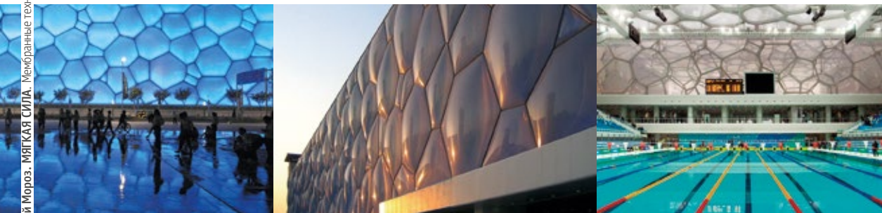
Water Cube. Национальный плавательный комплекс / Пекин. 2008. Проект – Роб Лесли Картер, PTW / Австралия Фасад покрыт 3 000 «пузырей» разнообразных размеров и причудливых форм. Площадь их колеблется до 70 м 2 . Высокотехнологичная «оболочка» улавливает до 90 % солнечной энергии, которая используется для подогрева воды в бассейне.
